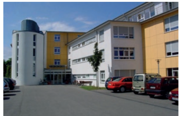
Eingangsbereich mit Parkplätzen
