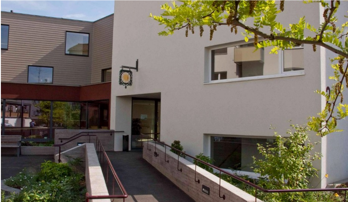
Eingangsbereich der Wohnanlage von der Hauptstraße her
