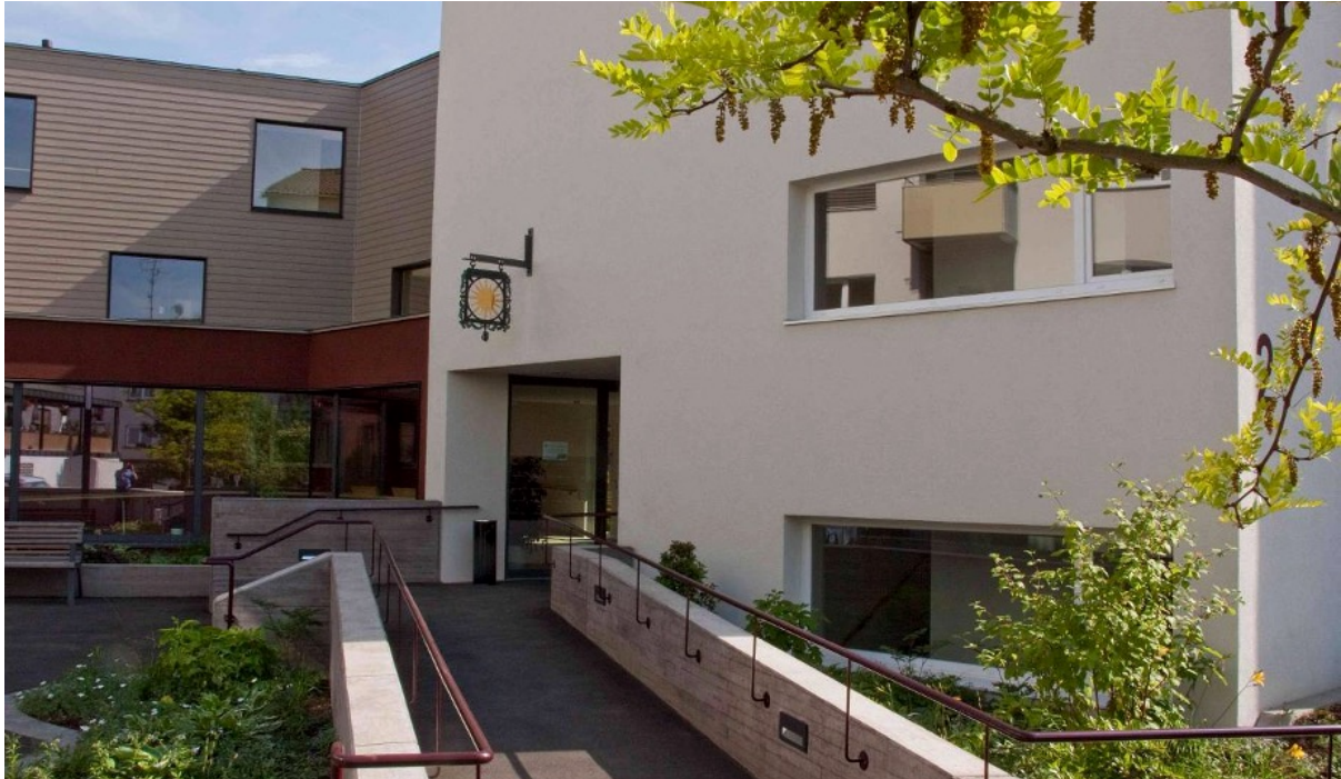
Eingangsbereich der Wohnanlage von der Hauptstraße her
